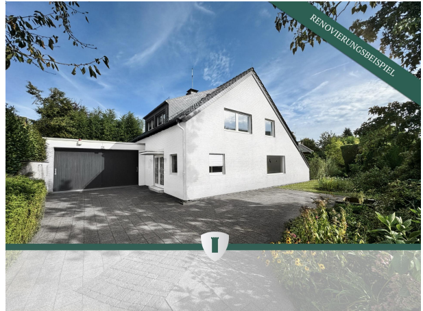
Frontansicht Renovierungsbeispiel Schleife
